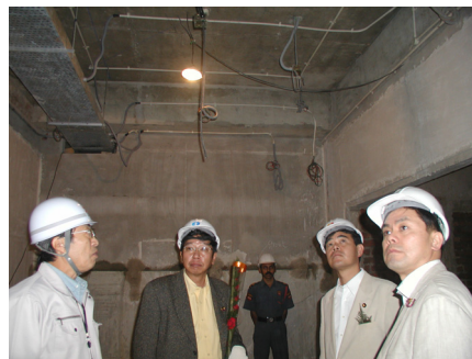
(写真) 施設内の建設状況を視察
