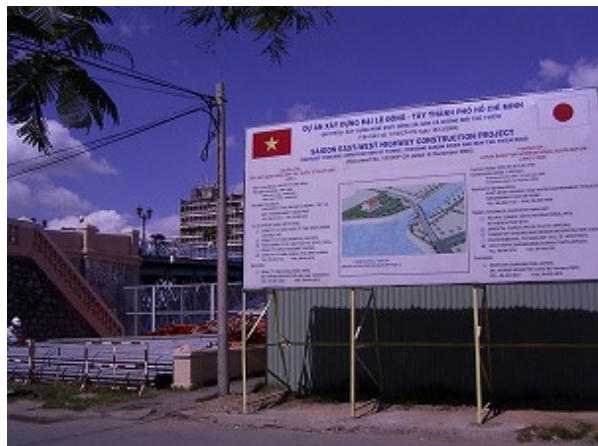
(写真) 建設現場
