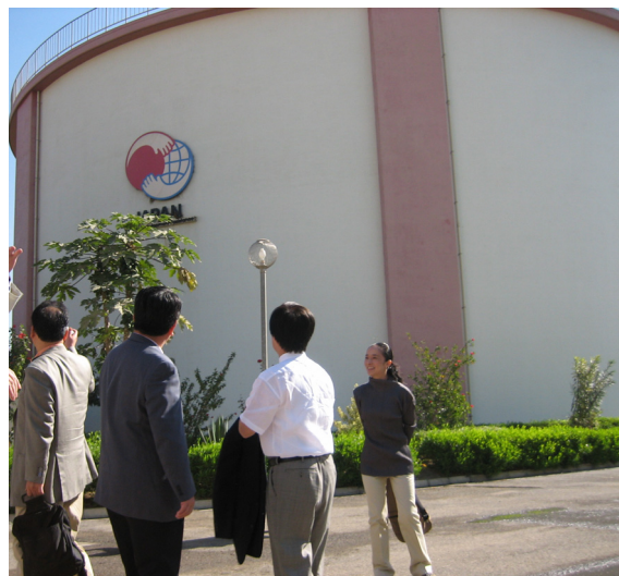
(写真) ODAマークが付けられた配水タンク
