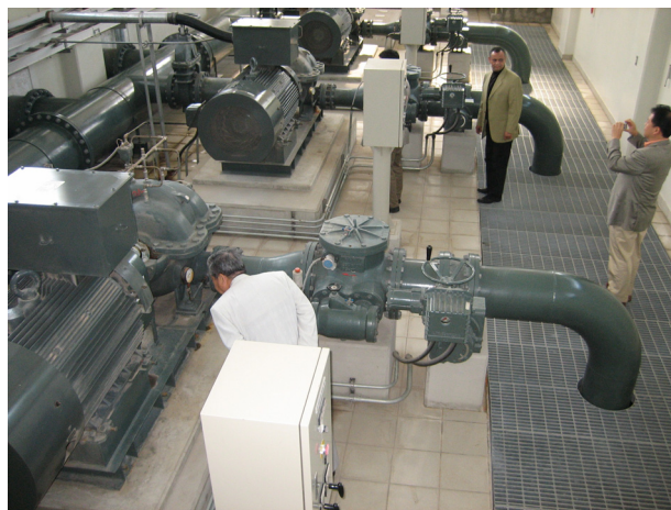
(写真) 配水施設を視察
