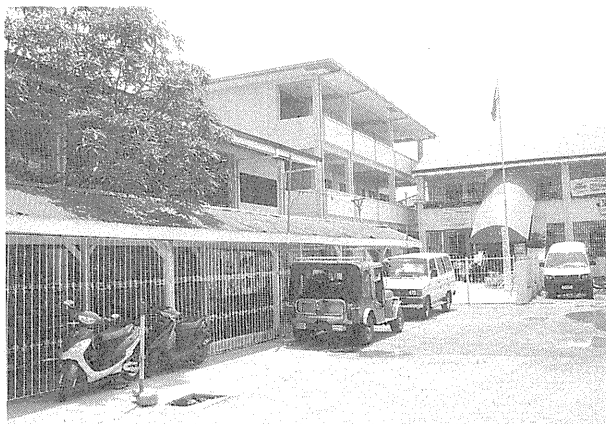
(写真) ナボタス公立中学校外観
