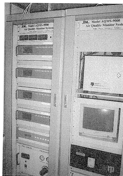
(写真) 大気モニタリング設備
