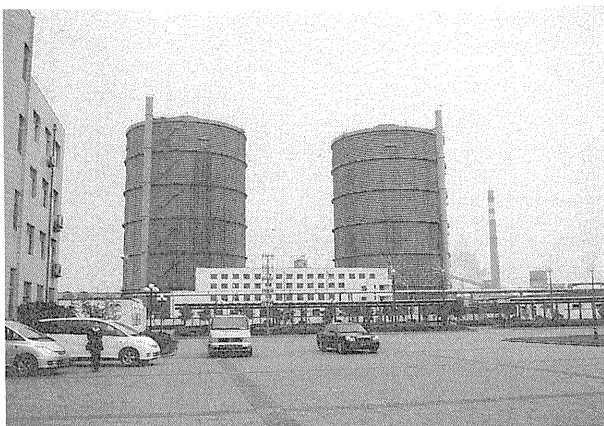
（写真）石炭ガス化プラント
